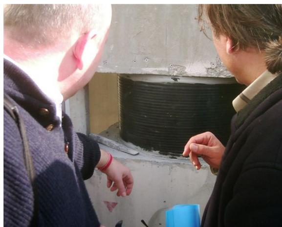
Figura 12 – Dettaglio di un LRB dopo l'installazione
