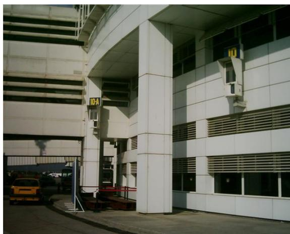
Figura 13 – Dopo il completamento dei lavori i pilastri sono stati nuovamente ricoperti dai pannelli di FRC che nascondono completamente l'intervento
